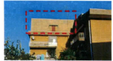
Appartamenti Pasiano di Pordenone via Taiaiori - 21500
